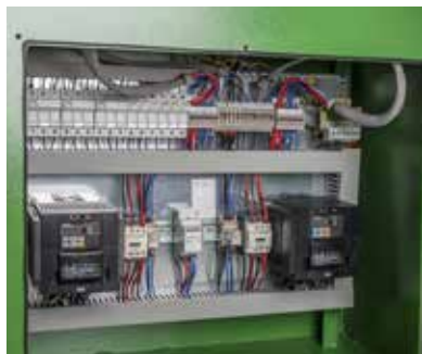
Particolare dell'impianto elettrico, dove si notano i due inverter.
